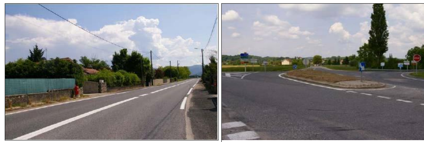
RD1075 à proximité du carrefour avec la RD 1084 Carrefour de la RD 12 et de la RD 1084
