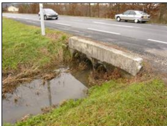
Le bief des Agneloux après une période de pluie (décembre 2008)
