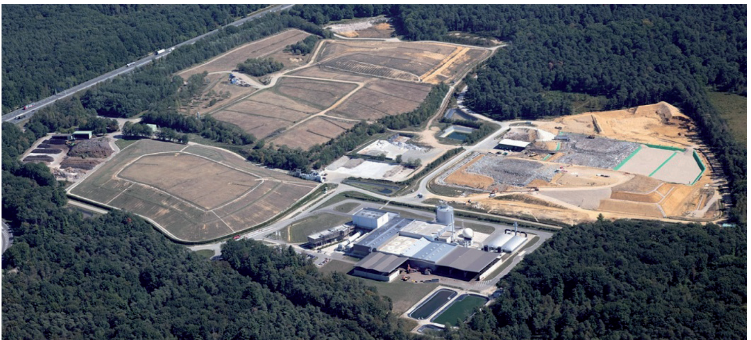
Le site de La Tienne en septembre 2018
